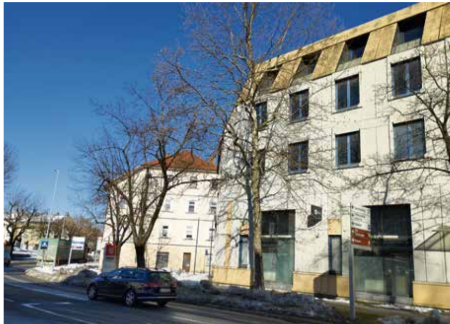
Toga občestna fasada na sodoben način nadaljuje strnjen niz obstoječe pozidave.
